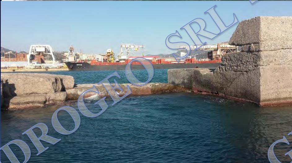
A seguito di una violenta mareggiata nel Dicembre 2019, la diga foranea a protezione di un'importante porto del Nord Italia, risultava gravemente danneggiata e necessitava di lavori di ripristino e messa in sicurezza in tempi stretti. Al fine di preparare una progettazione adeguata che interessasse sia il muro paraonde che i cassoni di basamento, risultava necessario un survey di dettaglio che rilevasse in unica soluzione sia la parte sommersa che la parte emersa.
