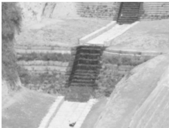
Figura 12. Ariano Irpino (AV), Fosso di Anzani. Dettaglio della terra rinforzata rinverditata.
