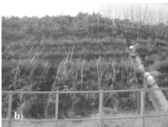
Figura 2. Via Montagna Spaccata (Napoli). a) Veduta aerea dell'intervento allestito per proteggere il sito da erosione areale. b) Particolare dell'intervento: viminata viva.
