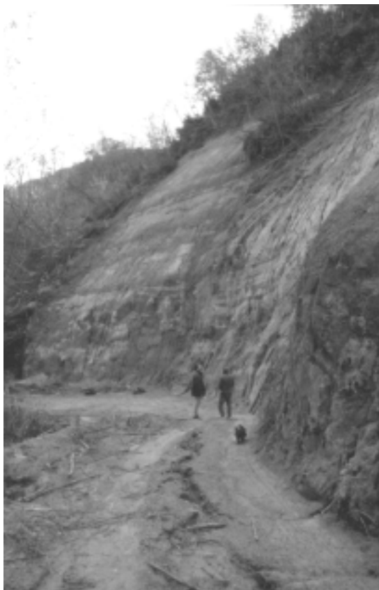
Figura 4. Vallone Bietola (Napoli). Stato dei versanti interni prima dell'intervento (gennaio 1997). In evidenza, frane da scorrimento traslativo in depositi piroclastici del III periodo flegreo.
