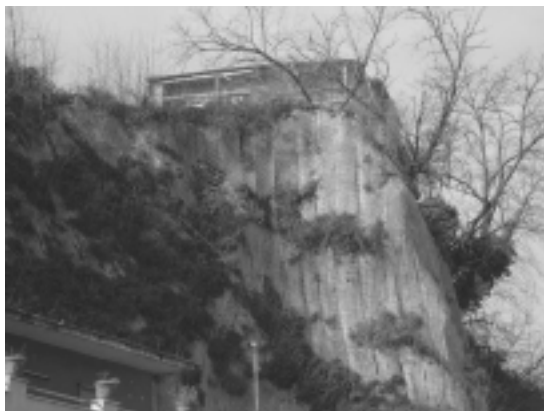
Figura 3. Via Montagna Spaccata (Napoli). Rivestimento vegetativo con reti e stuoie, rinverdito.
