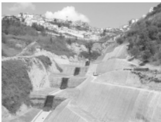
Figura 11. Ariano Irpino (AV), Fosso di Anzani. Opera combinata: terra rinforzata e rivestimenti con idrosemina. Lavoro in corso d'opera.
