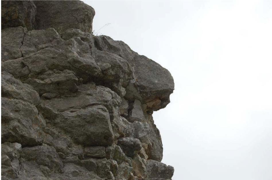
*Fig. 2.7. Instabilità di tipo 2: mensola tozza a sbalzo.*
