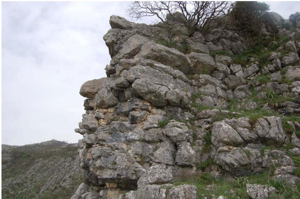
*Fig. 2.8. Instabilità di tipo 4 (ammasso roccioso suddiviso da strati che creano mensole a sbalzo).*
