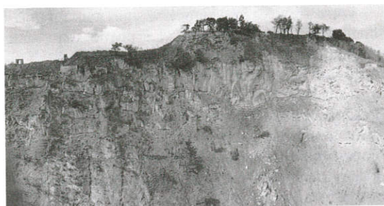
Figura 12. Il costone tufaceo della collina dei Camaldoli (lato Soccavo), intensamente fratturato e interessato da frequenti frane da crollo e/o ribaltamento.
